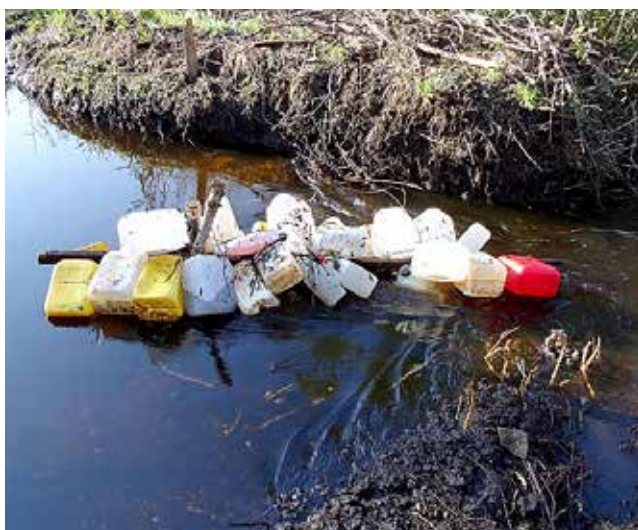
Kanisterkette unmittelbar nach Einbau
