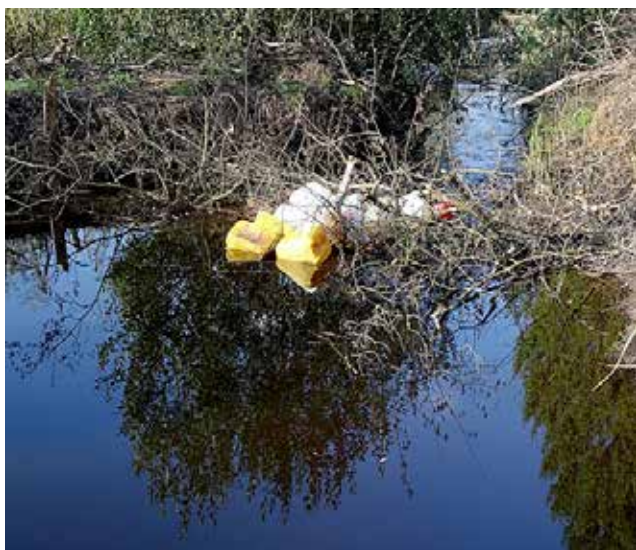
Kanistereinbau zur Offenhaltung einer Dammlücke
