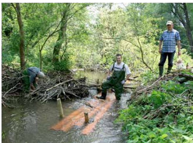
Einbau einer Dammdrainage durch Naturschutzwacht
