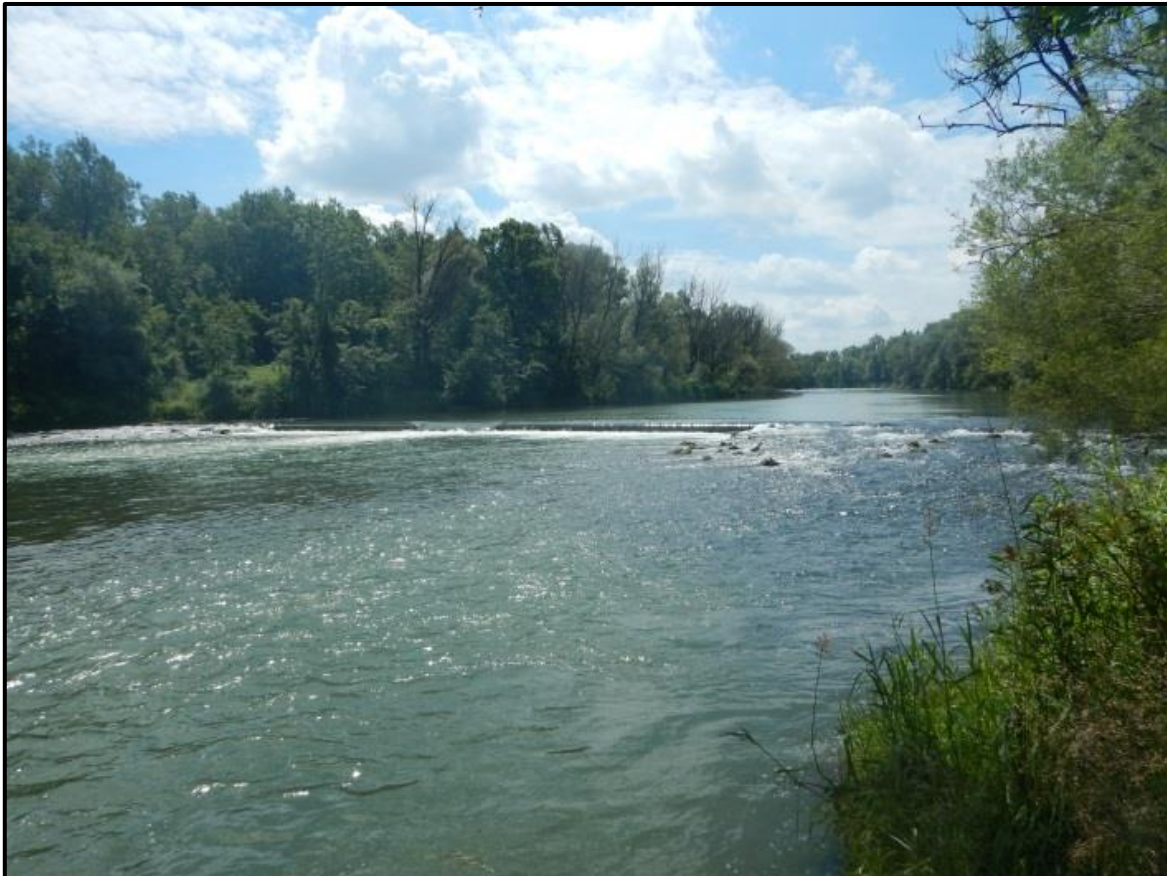
Abb. 1: Ansicht des Einleitbauwerkes bzw. der Sohlschwelle
