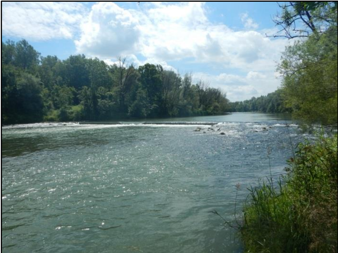
Abb. 1: Ansicht des Einleitbauwerkes bzw. der Sohlschwelle
